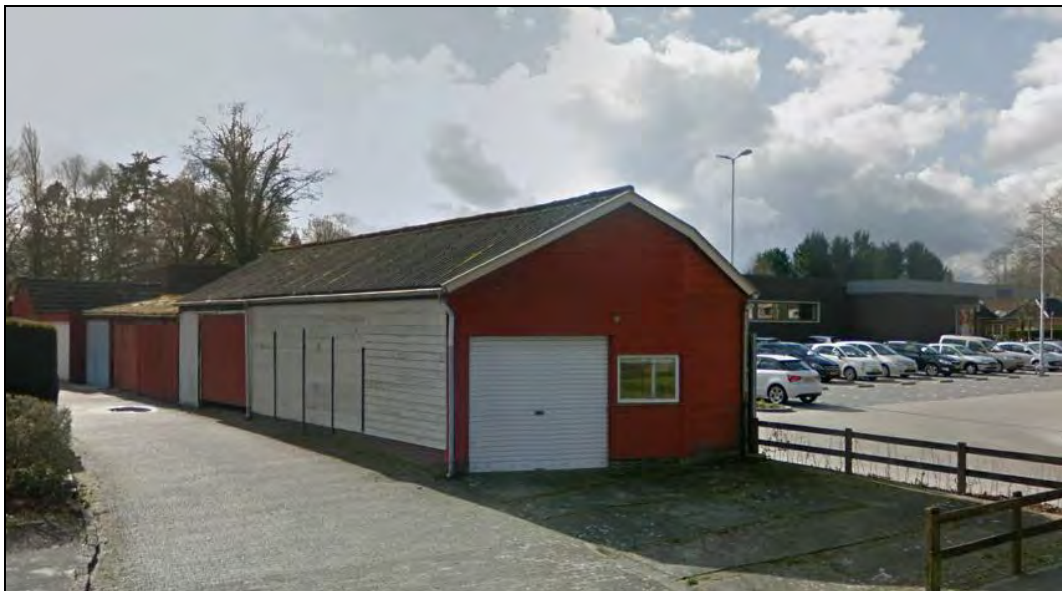
Figuur 4.1-2: Te slopen schuren/garages in het plangebied.
