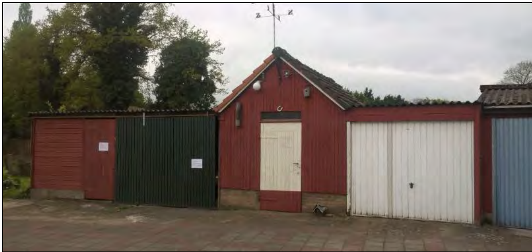
Figuur 4.1-1: Te slopen schuren/garages in het plangebied.
