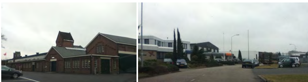
Afbeelding 2.4 Oudere en nieuwere bebouwing op het bedrijventerrein
